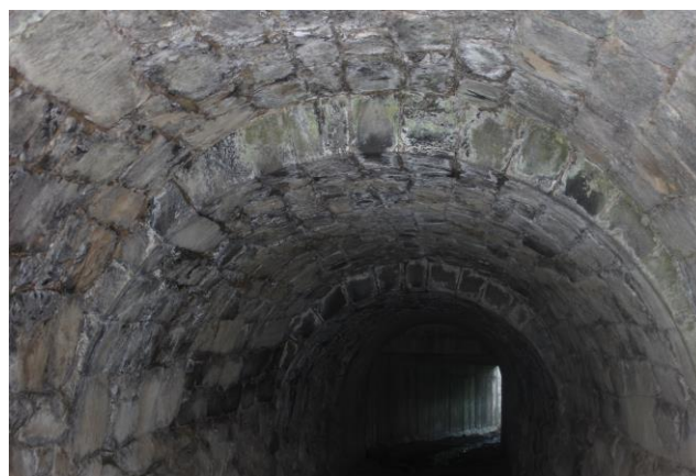
Obrázok - Odstupňovanie stropu kamennej klenby
